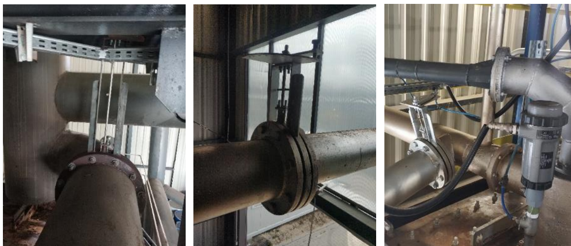
Rys. 37. Miejsce wstawienia dodatkowych przepustnic regulacyjnych - od lewej: na kanale do wyrzutni; na kanale powietrza gorącego; do kanału powietrza zimnego wtórnego [aut.].
