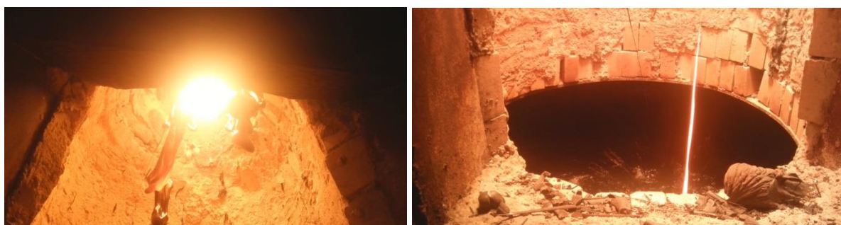
Rys. 15. Sople roztopionego popiołu wpadające do basenu gaszącego, wodnego [39].
