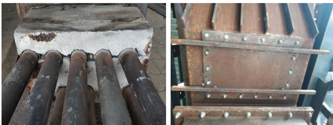
Rys. 36. Demontaż rusztu granulacyjnego pierwszego i wypełnienie stołu topienia zaślepką betonową z betonu izolacyjnego i ogniotrwałego.[aut.]
